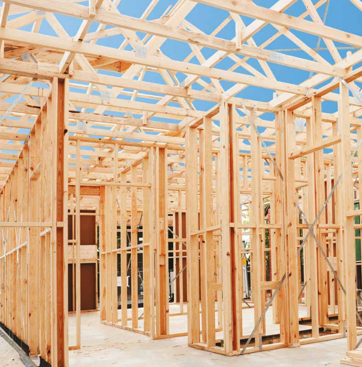
Dettaglio di una casa in costruzione. A house under construction.
