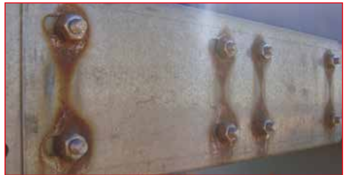
Esempio di corrosione galvanica dovuta dall'accoppiamento di dadi e bulloni in acciaio INOX su una piastra in acciaio.
